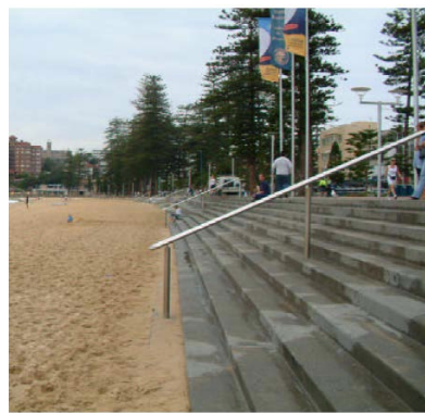
(d) Concrete stepped face (Manly Council)
